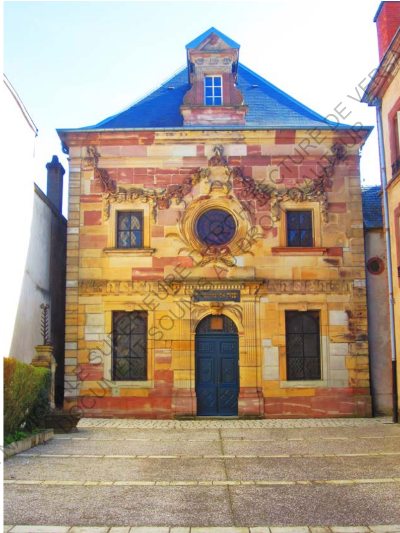
Façade sur cour de la synagogue de Lunéville ©Aimelaime
