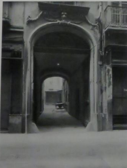
Via S. Tomaso 26. - Portone e stia ora demoliti
