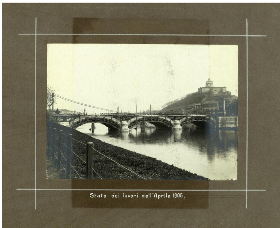
Fig. 27 : « Stato dei lavori nell'aprile 1906 », Costruzione del ponte monumentale Umberto I° in Torino, 1907?, ASCT
