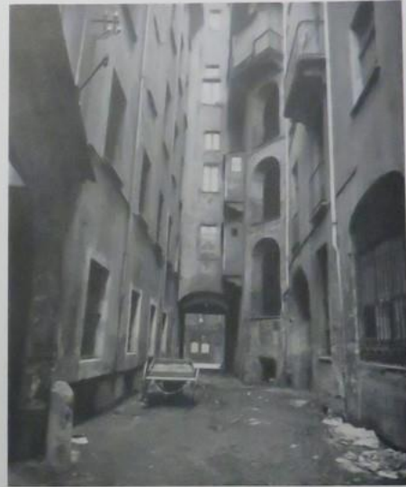
Via S. Tomaso 26. - Cortile
