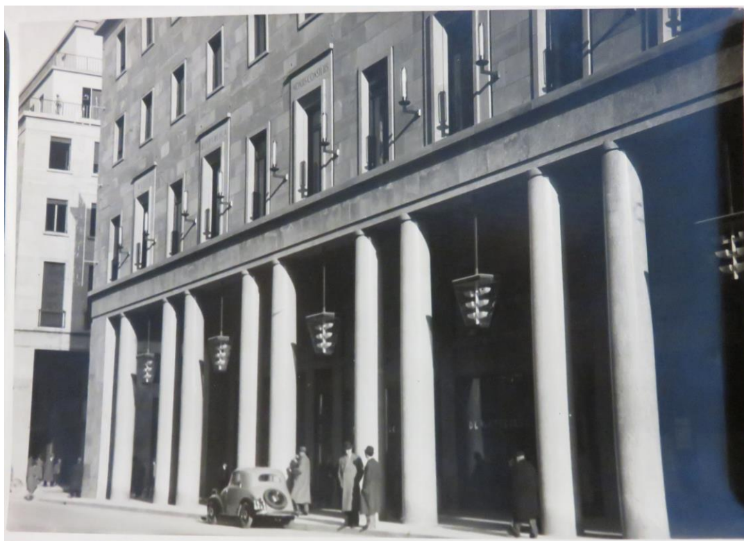
Fig. 31 : Mario Balzanelli, « Via Roma (dopo i lavori) vers 1937, fonds Balzanelli, Biblioteca Civica
