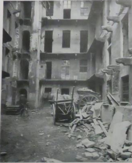
Via S. Tomaso 24. - Interno di casa in demolizione all'angolo di via Bertola
