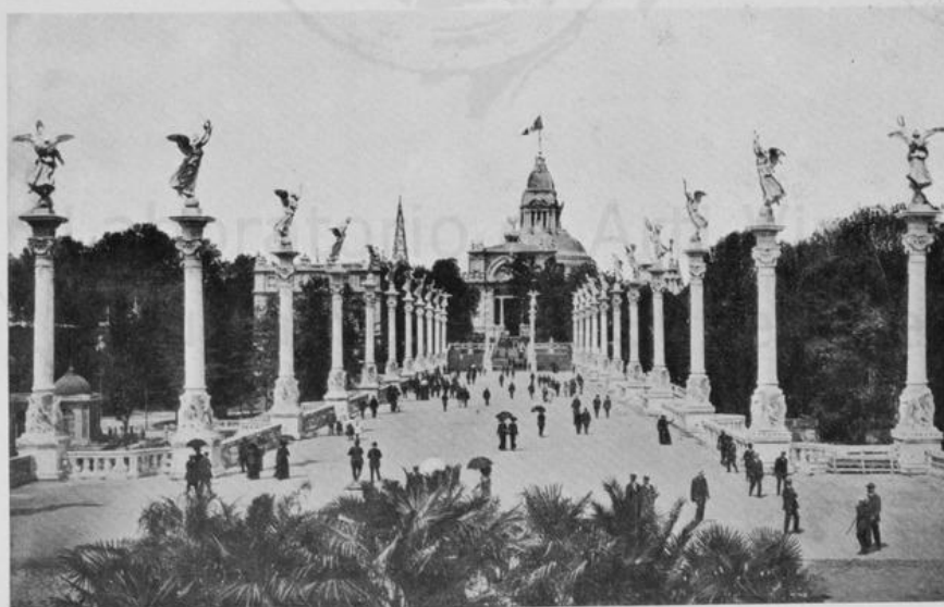
IL PONTE MONUMENTALE DALLA RIVA DESTRA — IN FONDO IL PALAZZO DELLE FESTE.
