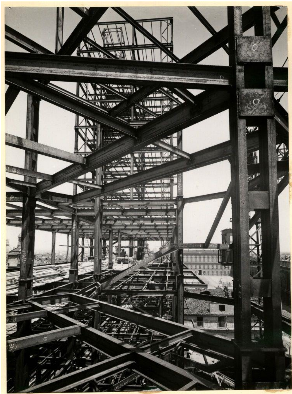
Fig. 35 : Mario Gabinio, « Torino, Torre Littoria, Via Viotti 1, La struttura mettalica », 1933, Archivio Gotografico della Fondazione Torino Musei
