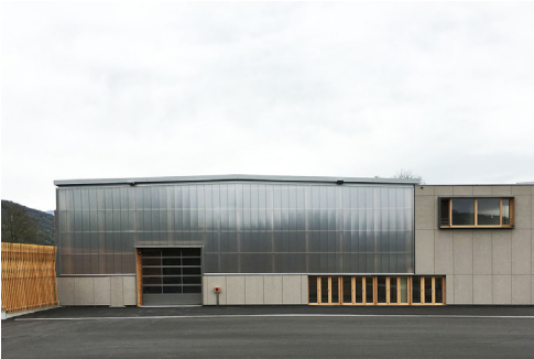
illustration III.16 : Halle d'entreprises Adre-Alba par Amiot-Lombard Architectes © crédits photos CBS-CBT - La Rochette, Savoie [ http://www.cbs-cbt.com/fr/realisations/Espace-Ardea-Alba,-la-Rochette-(73)-6-0-6 ]
