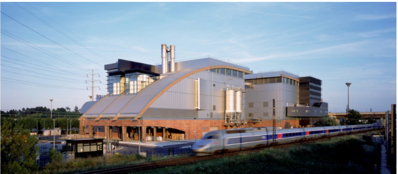
illustration III.19 : Usine de valorisation des déchets par Lobjoy - Bouvier-Boisseau - Créteil, Hauts-de-Seine [ https://www.archiliste.fr/architectes-lobjoy-et-bouvier/creteil-usine-de-valorisation-des-dechets ]
