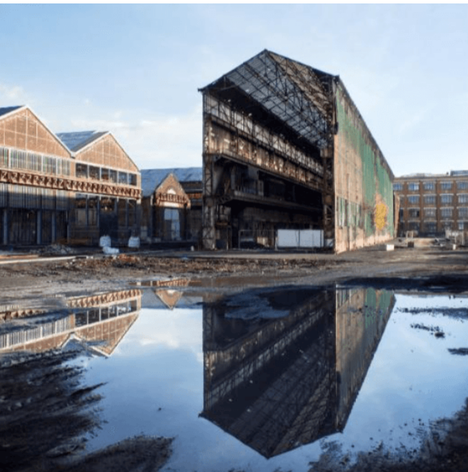
illustration III.9 : Ancienne halle industrielle Fives Cail - Lille - appel à projets pour sa réhabilitation et occupation. 2018 [https://batjournal.com/appel-a-projets-pour-la-rehabilitation-et-loccupation-dune-ancienne-halle-industrielle/101124]
