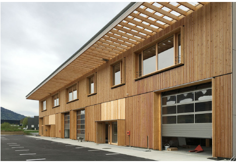
illustration III.14 : Halle d'entreprises Adre-Alba par Amiot-Lombard Architectes © crédits photos CBS-CBT - La Rochette, Savoie [ http://www.cbs-cbt.com/fr/realisations/Espace-Ardea-Alba,-la-Rochette-(73)-6-0-6 ]
