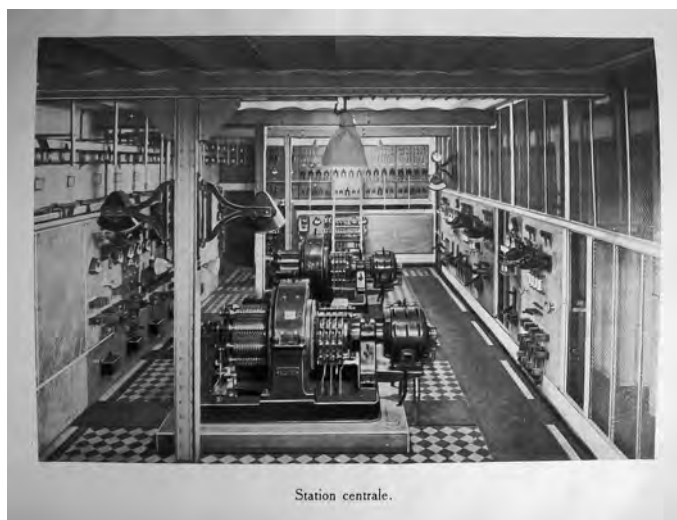
Fig. 31: Photographie de la station électrique centrale, 1927, Cinémathèque Française, Fonds Louis Gaumont
