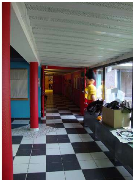
FIGURE 3.5 – Carrelage dans le couloir
