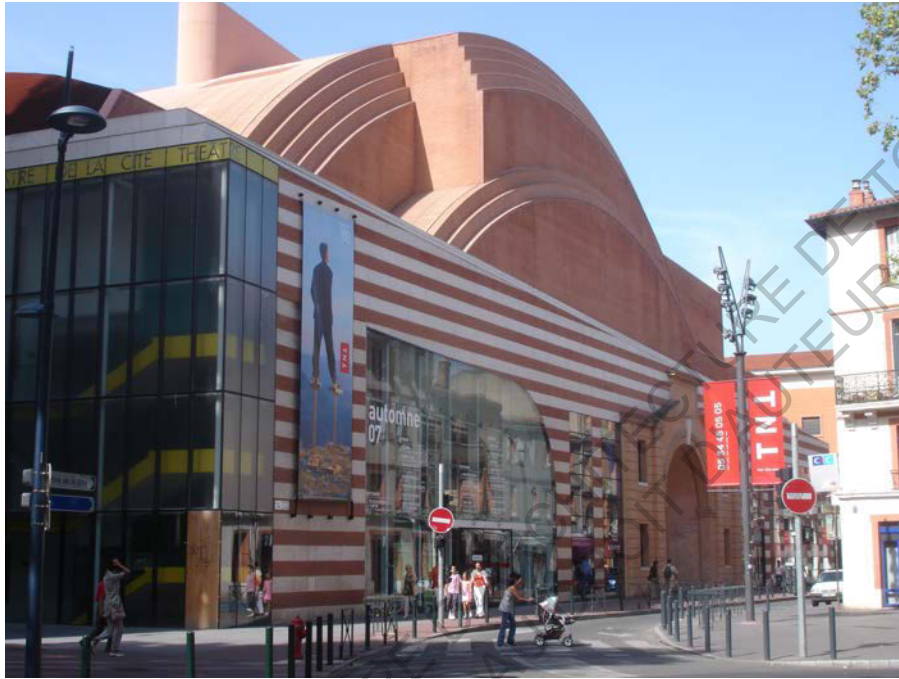
Fig. 08- Vieux portique collé sur la façade du théâtre Sarfati.
