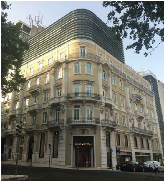
Fig. 18,a - Bâtiment Louis Vuitton sur l'Avenida da Liberdade.
