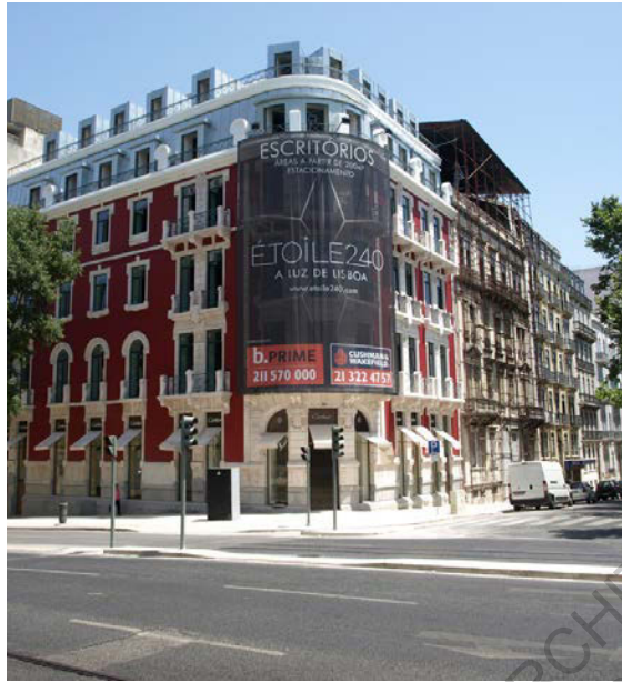
Fig. 19 - Bâtiment Cartier sur l'Avenida da Liberdade.
