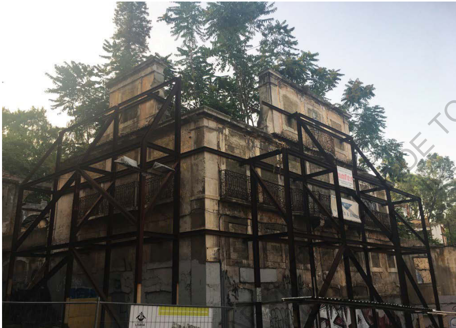
Fig. 10- Façade étayée, vue extérieure, Lisbonne, Portugal
