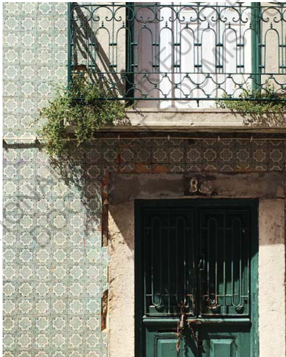
Fig. 16,b – Façades typiquement lisboète en azulejos.
