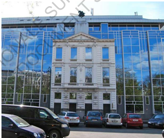
Fig. 07- Maison de maître à Bruxelles L'ancienne maison de maître édifiée par Henri Maquet en 1874 fait désormais partie intégrante d'un immeuble de bureaux, érigé vers 1989. De l'ancienne maison, seule subsiste la façade.
