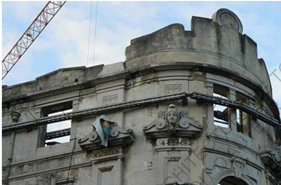
Fig. 25 - Maintien de la façade existante lors du chantier.
