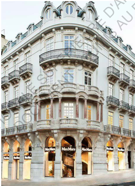
Fig. 18,b - Bâtiment MaxMara sur l'Avenida da Liberdade.
