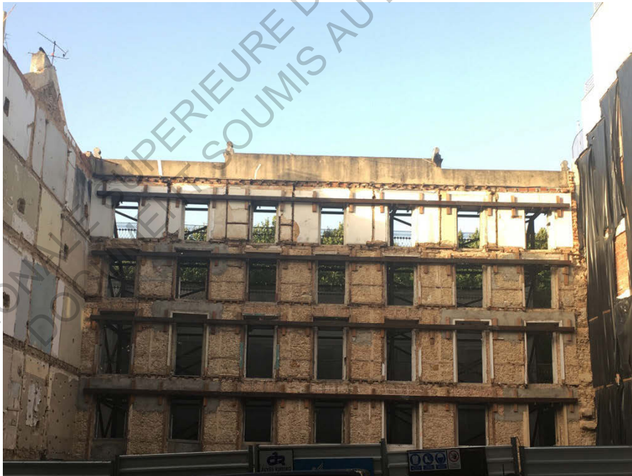
Fig. 11- Façade étayée, vue intérieure, Lisbonne, Portugal
