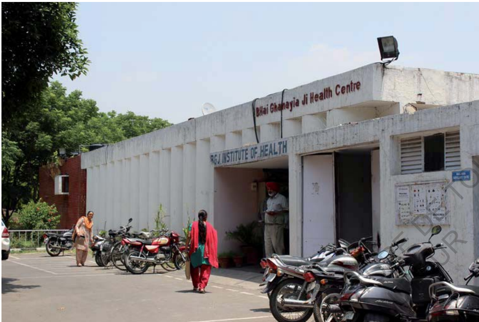
[128.] Façade sud et ses brise-soleil verticaux - Photographie du Health Center - S14.
