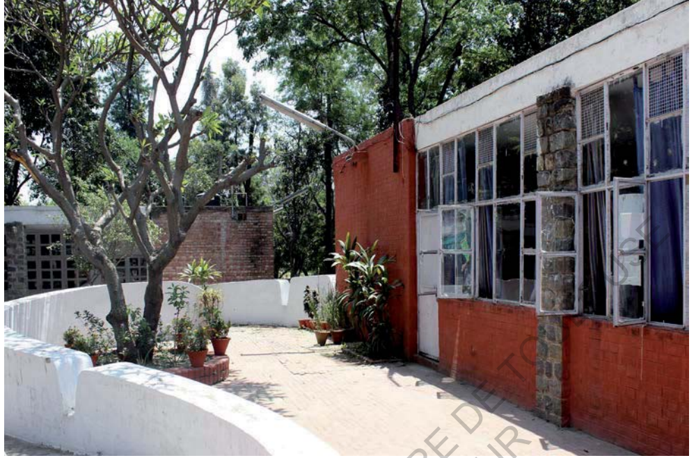
[211.] Fermeture d'une véranda avec du vitrage
