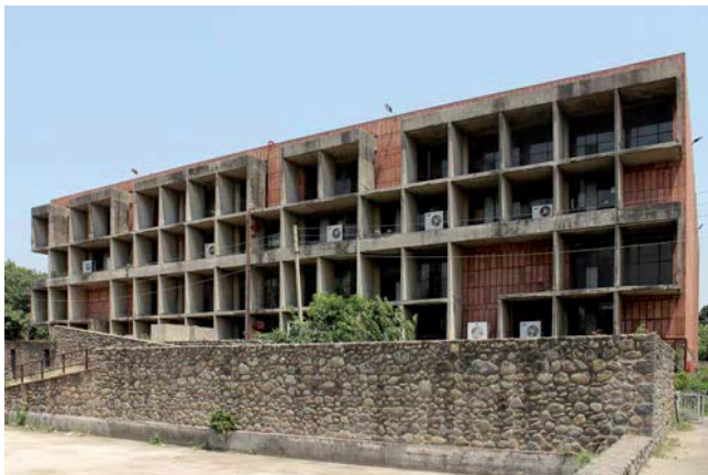
[147.] Façade Nord-Est - Photographie de la University Library - S14.
