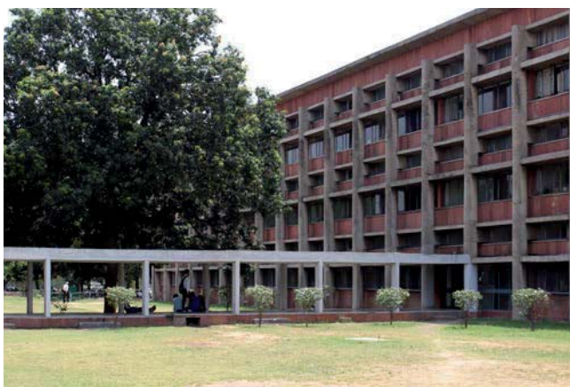
[148.] Façade Nord - Photographie du Science College - S14.
