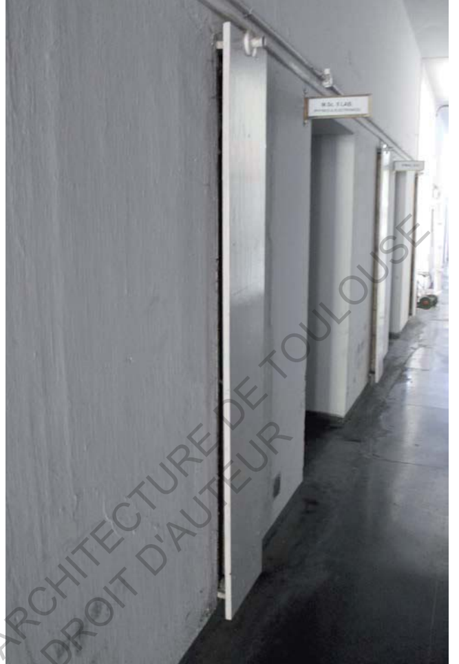
[188.] Système de grilles d'aération sur couloir - Photographie du Science College - S14.
