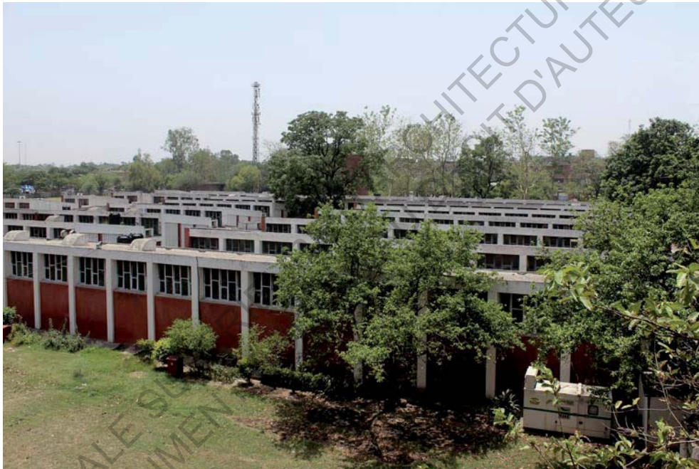
[166.] Nappe de sheds - Photographie de l'école Polytechnique - S26.
