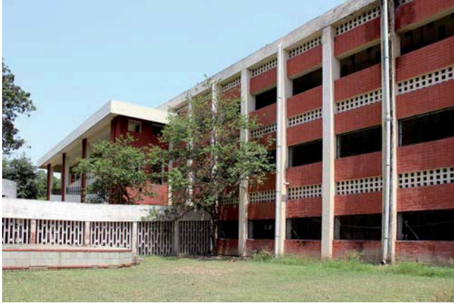
[159.] Claustra de briques - Coursives de Polytechnic- S26.
