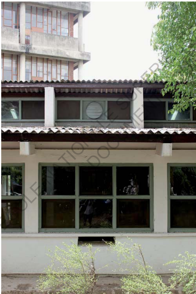
[195.] Façade Nord et shed - Photographie du bureau des Architectes - S19.
