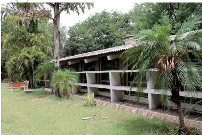
[150.] Façade Sud - Photographie de l'Architects Office - S19.
