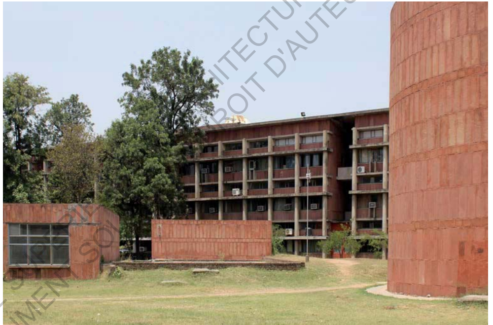
[212.] Ajout de nombreux climatiseurs en façade, sur des supports sauvages.
