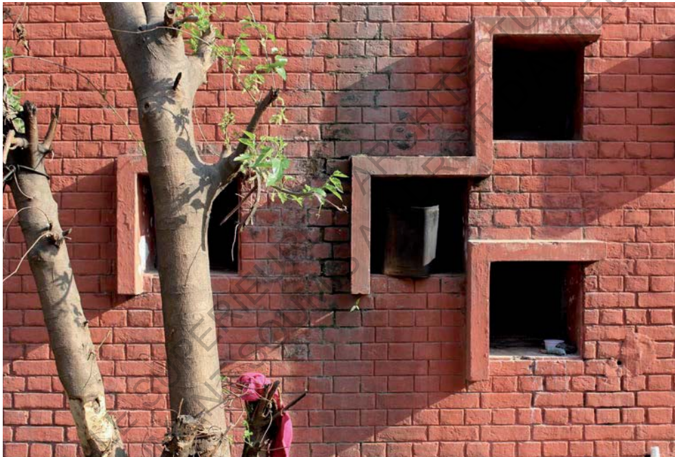
[152.] Façade Nord-Ouest et équerres préfabriquées - Photographie de la Nursery School - S23.
