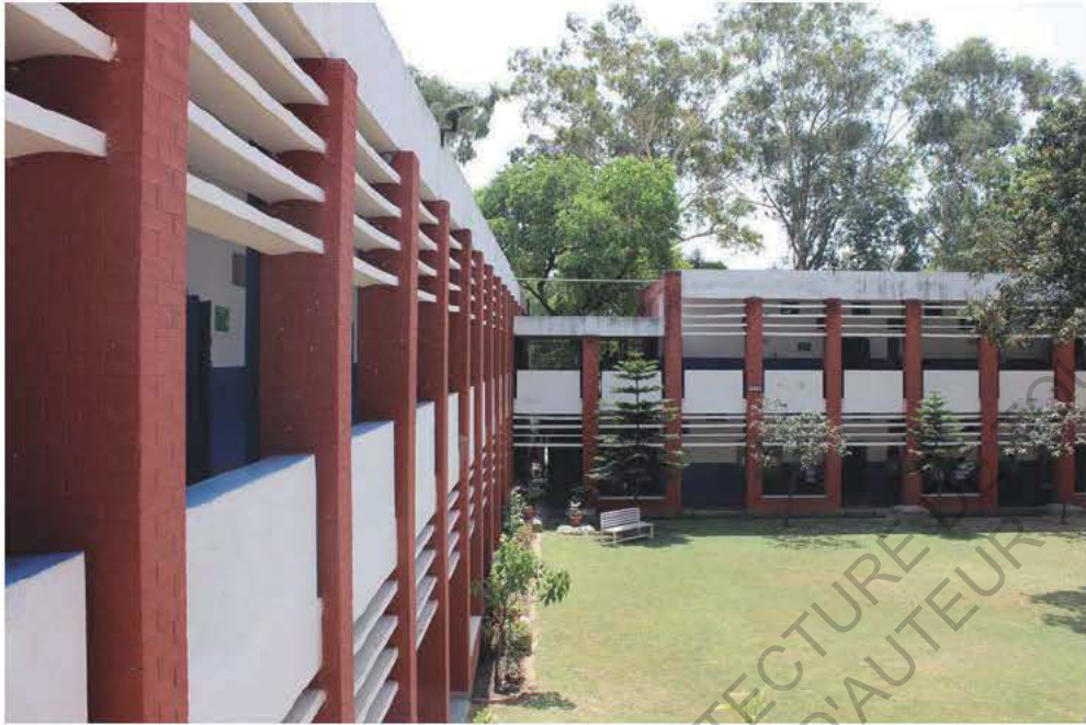
[130.] Façade sud et ses brise-soleil horizontaux - Photographie de la Secondary School - S16.
