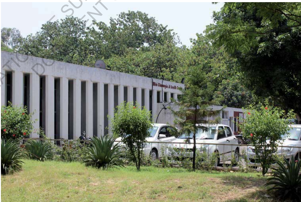
[129.] Façade sud et ses brise-soleil verticaux - Photographie du Health Center - S14.
