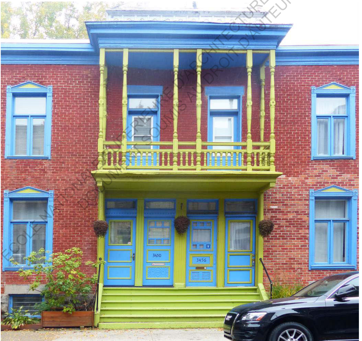
Photographie 7 : Façade d'un duplex avec marge de recul avant
