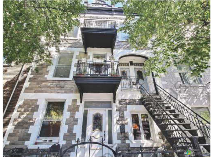
1 Photographie 16 : Façade sur rue
