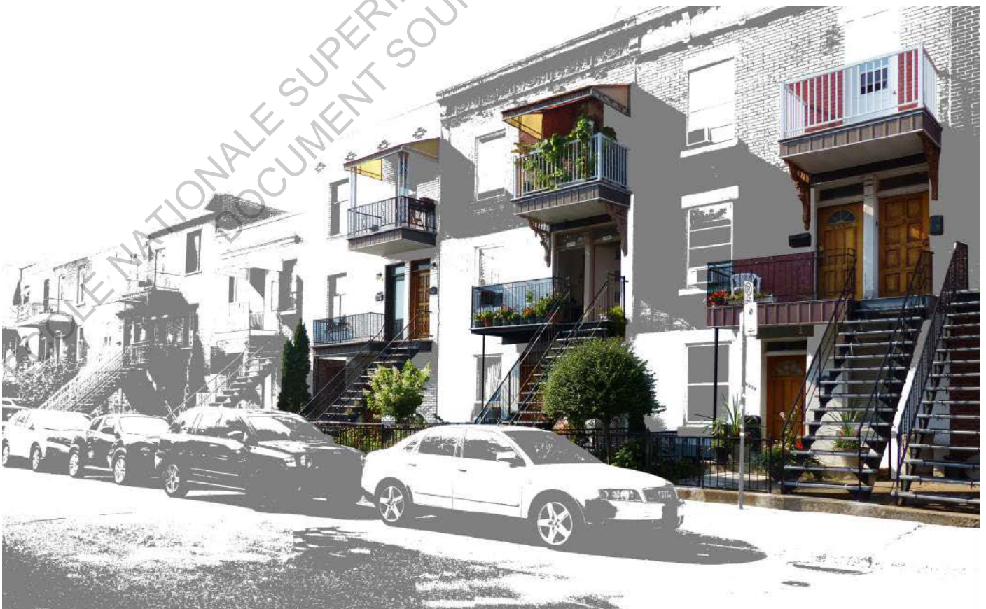
Photographie 23 : Façade du plex étudié
