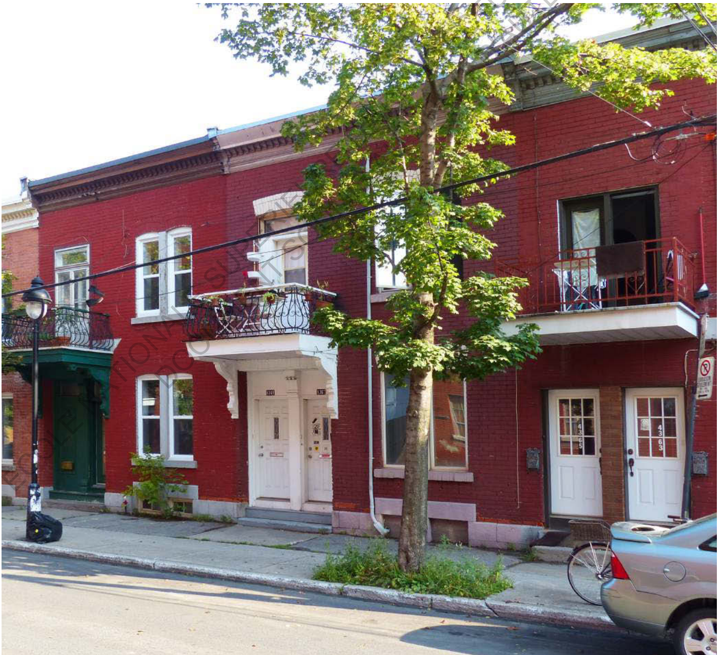
Photographie 6 : Façade d'un duplex sans marge de recul avant
