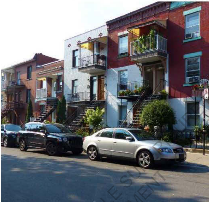
Photographie 11 : Façade d'un triplex avec escalier droit
