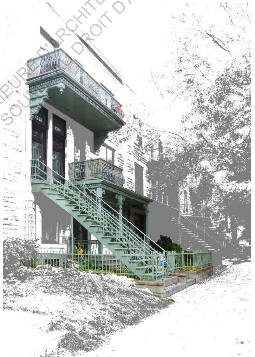
Photographie 25 : Façade du plex étudié
