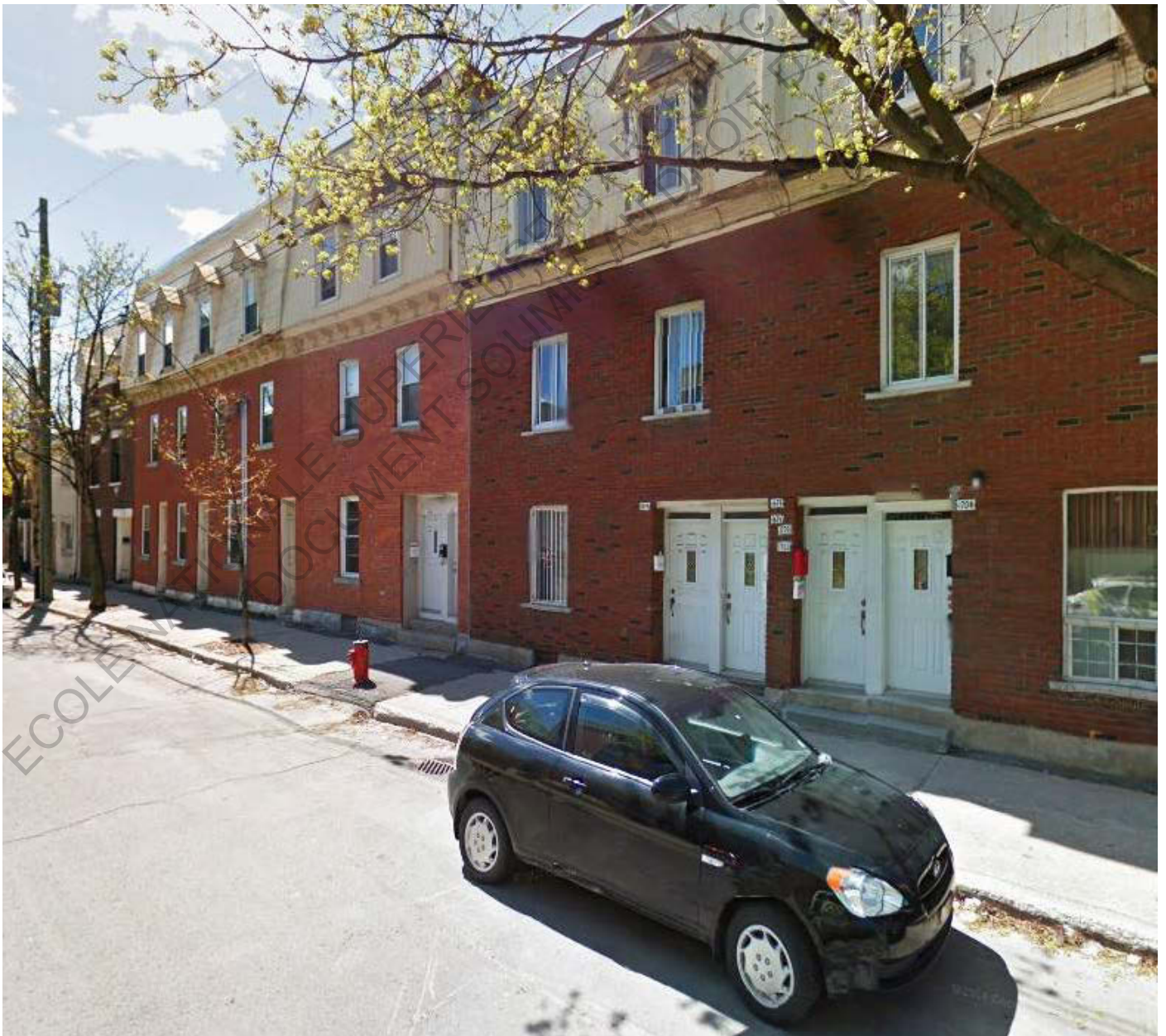
Photographie 10 : Façade d'un triplex avec escalier intérieur
