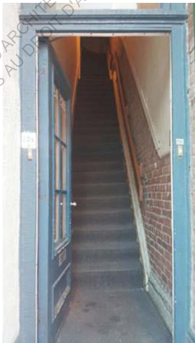
Photographies 36 : Escalier intérieur d'un plex
