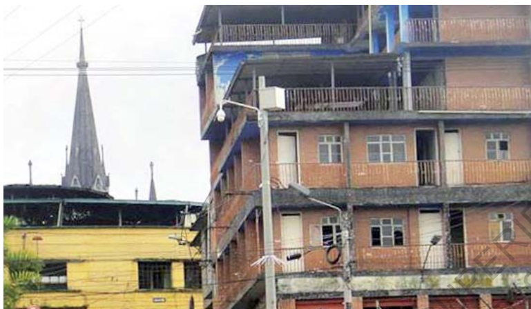
Haut: le sommet de la cathédrale de Manizales, derrière le marché central La Galeria (en jaune) et un immeuble d'habitations, vue depuis le Terminalito de Jeeps à San José, mars 2017, Y.V.
