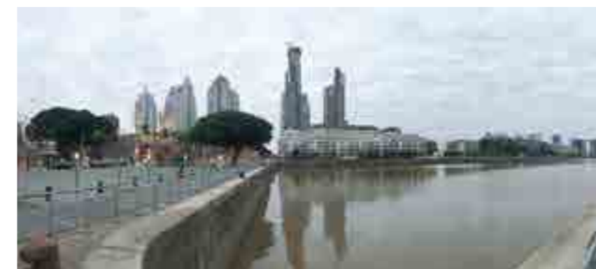
Figure 31. Photographie panoramique du Dock 2 Source : CASTRO Pierre-Louis, 2017
