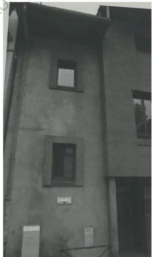
FIGURE 9 / Photo de la cage d'escalier du centre de la Daurade de Michel GALAVIELLE
