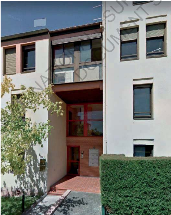
FIGURE 36 / Photo de l'entrée de l'opération Habitat collectif avec une alliance de matériaux locaux et universelles
