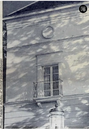
... «pastiche», décalqué sur l'architecture haussmannienne.
