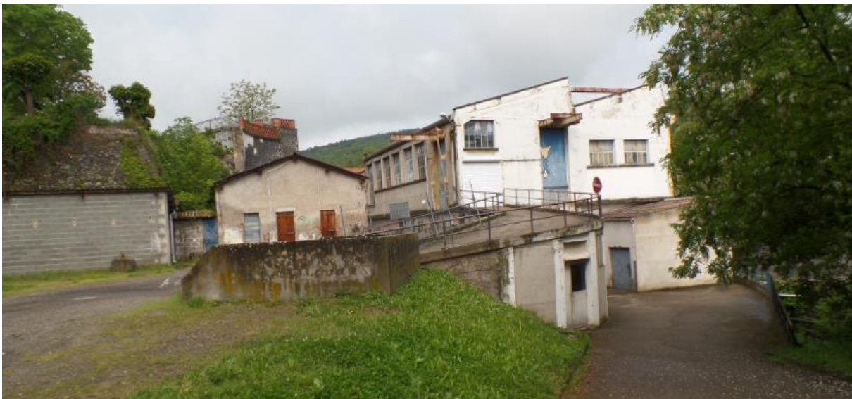
Fig. n°1 : Les bâtiments de la papeterie de Saint-Amant-Tallende © E. Chaumat - 2018
