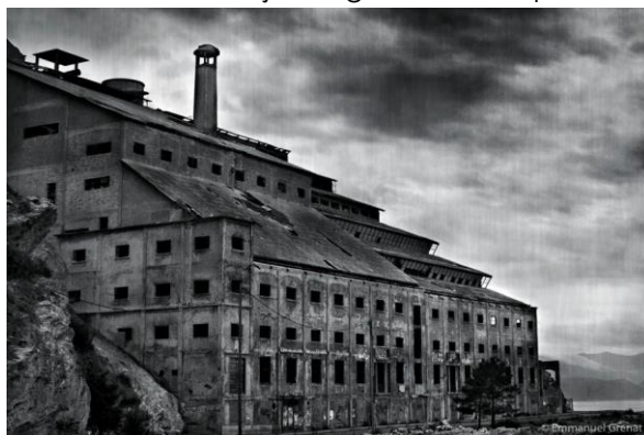
Figure 51 L'usine désaffectée (Photo Emmanuel Grenat)
