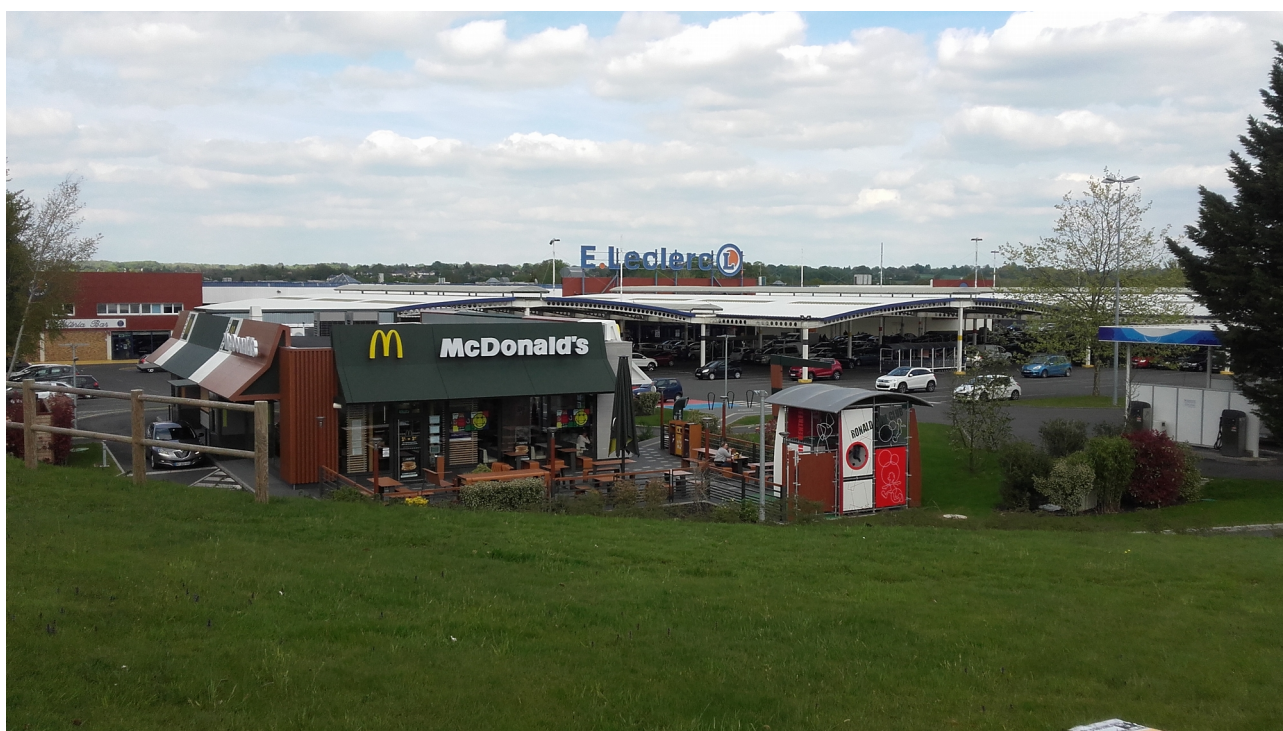
Fig. 65. Le centre commercial de La Ferté-Macé
