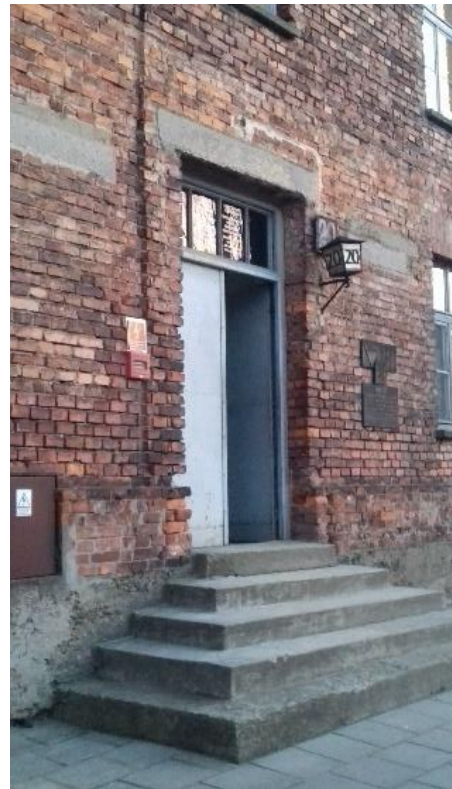
Figure 36 : Entrée du bloc 20 dédié aux déportés de France. 2019.
