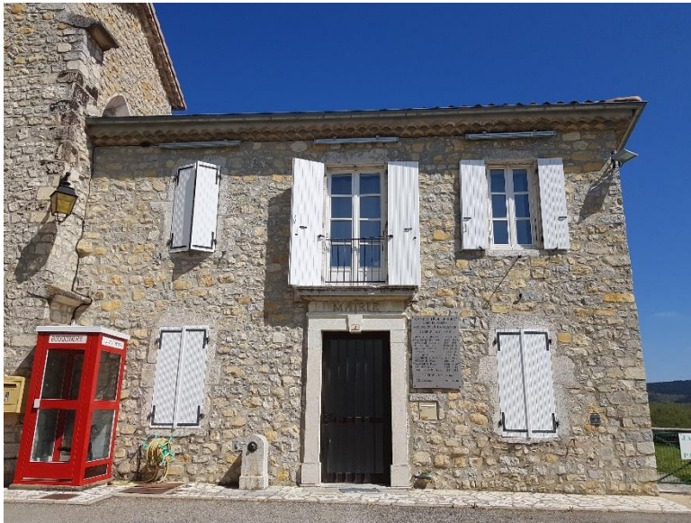
Bâtiment de la mairie actuelle
