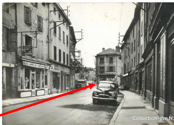
Rue des fossés : magasin de meubles derrière la voiture.
