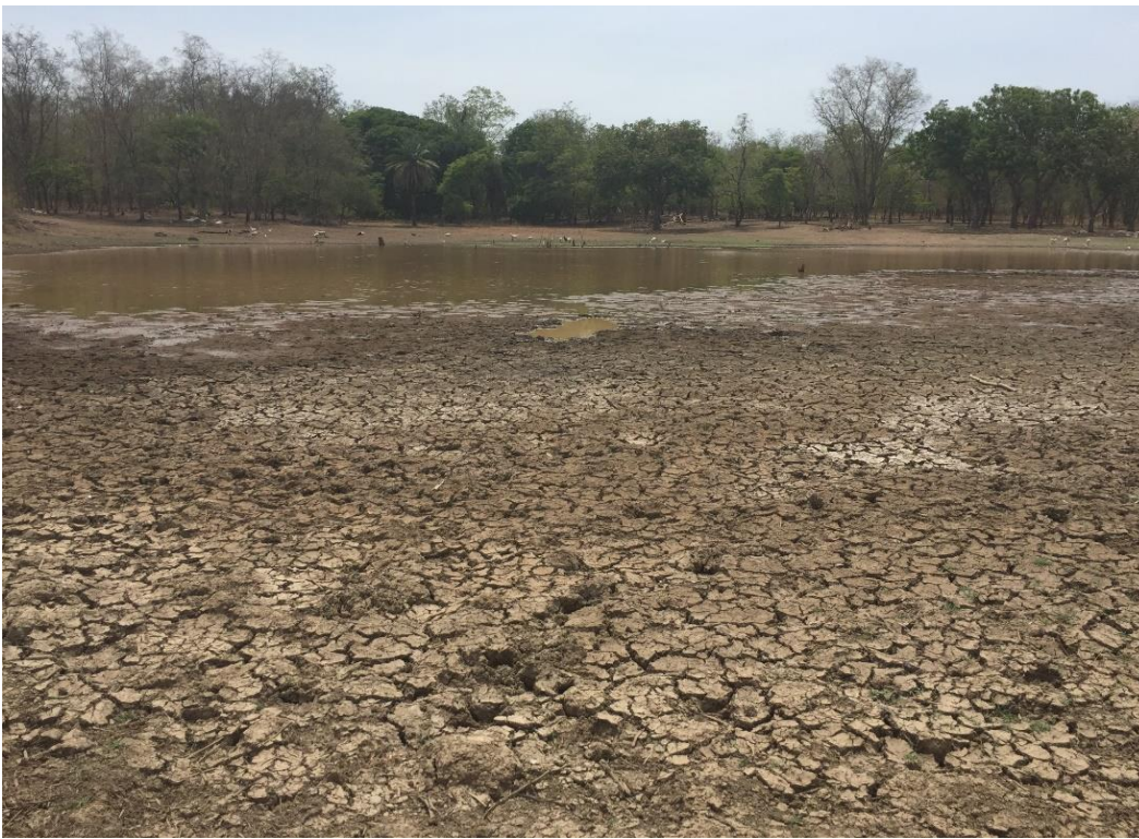
Figure 14 : Le barrage pastoral de Lagben ne permet plus d'abreuver les bêtes en fin de saison sèche, (15/04), S. PLOUVIEZ
