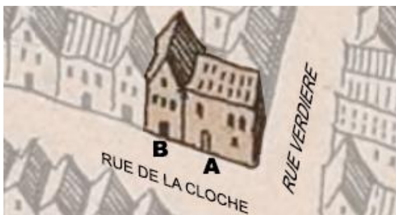
Maisons à l'angle de la rue de la Cloche et de rue Verdière en 1620 314
