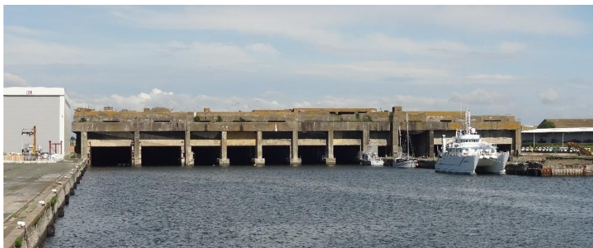
Alvéoles de l'ancienne base sous-marine allemande à la Pallice 20
