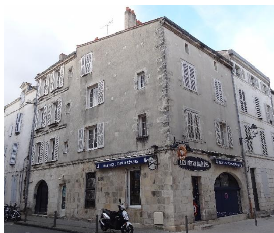
Bâtiment situé au 2 rue de la Cloche à la Rochelle 303
