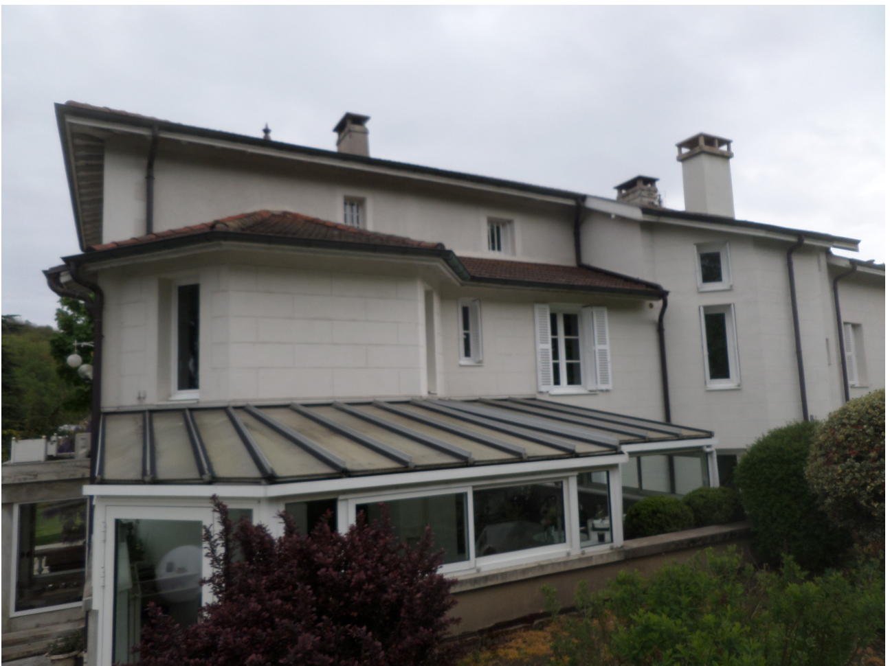
Fig. 59 – Vue de l'arrière de la bâtisse
