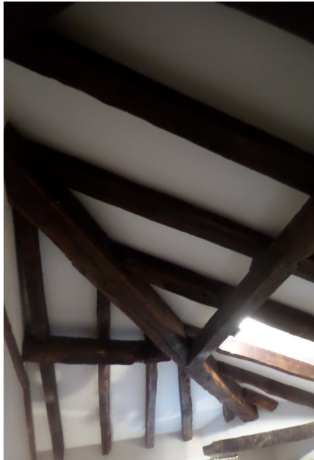
Fig. 55 – Les poutres anciennes dans une chambre
