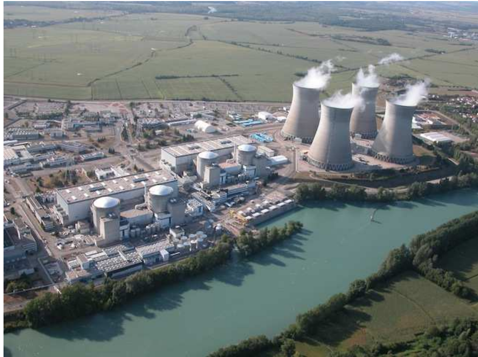
Fig. 5 – Vue aérienne du CNPE Du Bugey
