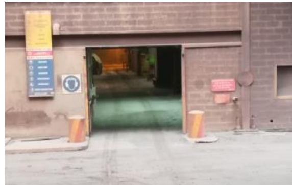
Photo de l'entrée du bâtiment de fabrication PCB3 Source : photo personnelle
