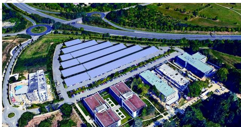
Figure 7 : Vue aérienne de l'installation des panneaux solaires sur un des parkings du Zénith de Nantes.
