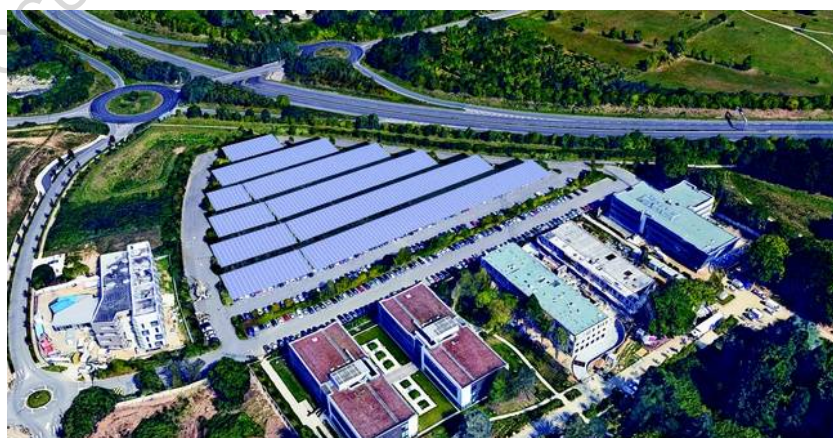
Figure 7 : Vue aérienne de l'installation des panneaux solaires sur un des parkings du Zénith de Nantes.
