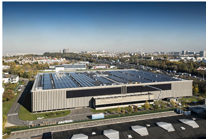
Figure 6 : Installation de panneaux solaires et panneaux photovoltaïques sur un réservoir d'eau potable à l'Hay-les-Roses (Val-de-Marne).
