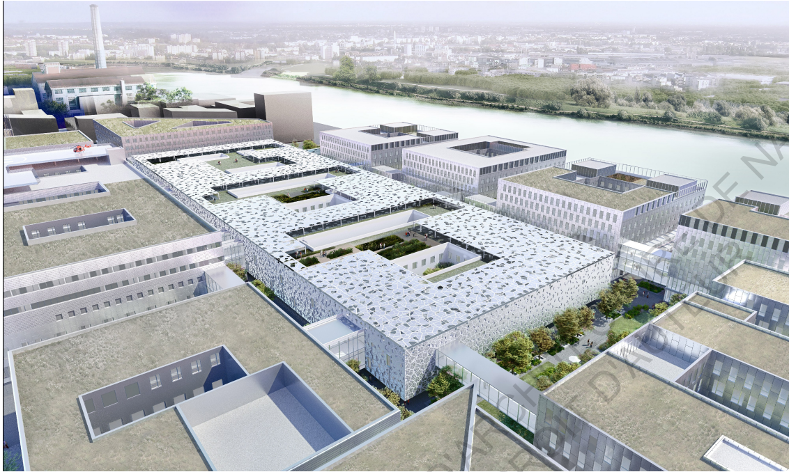
CHU, source: SAMOA. Perspective. Futur Centre Hospitalier Universitaire (CHU). Architectes _ Art & Build, Pargade Architectes, Artelia, Signes Paysage. Maîtrise d'ouvrage_ CHU de Nantes. Nantes (Loire-Atlantique) © Art & Build
