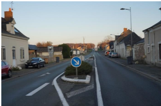
Figure 4 : Vue de la traverse de bourg d'Echemiré (AVEC, 2019)
