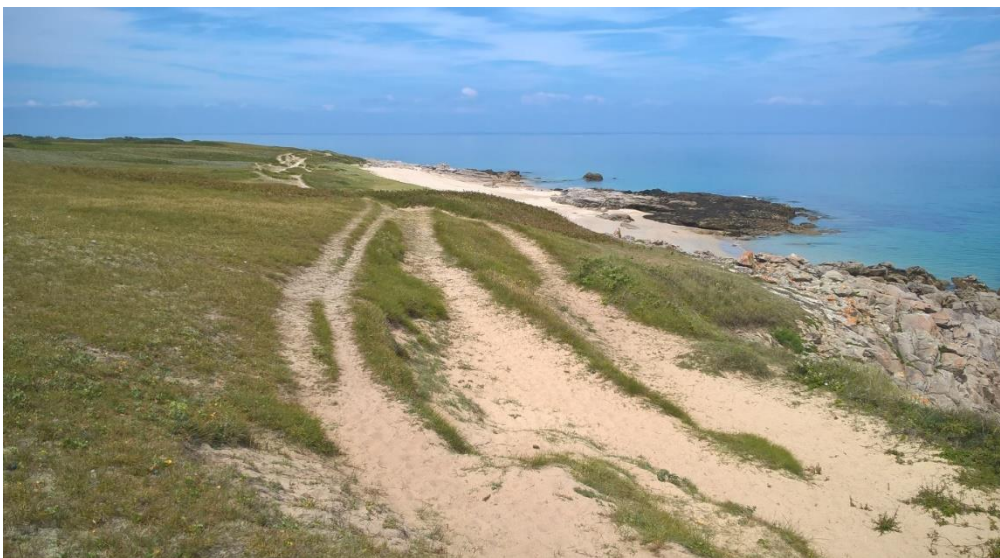
Figure 20 : Sentier côtier inutilement multiplié au nord-est d'Hœdic, du fait de la pente et de l'absence d'un revêtement stable (Bonneau B. 2019)
