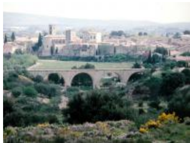
Le Pont de l'Intérêt local date des années 1870
