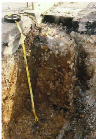
Photo 27. Profil de sol avant travaux
