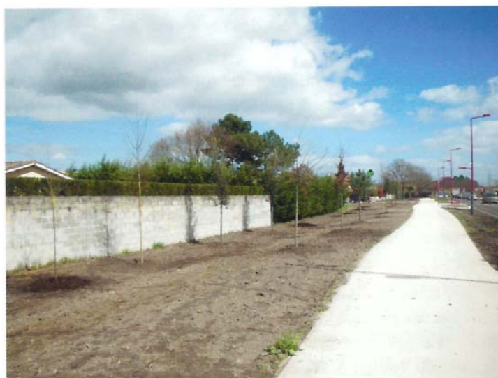
Photo 41. Vue d'ensemble de l'alignement après plantation
