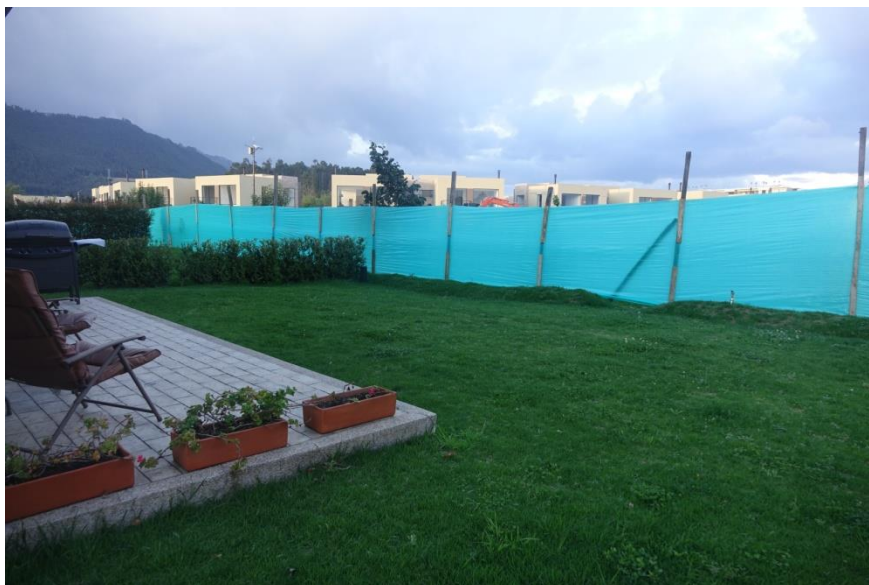
PHOTO 16. PARTIE EN TRAVAUX DERRIERE LE RIDEAU VERT. VUE DEPUIS LE JARDIN DE MON HÔTE
