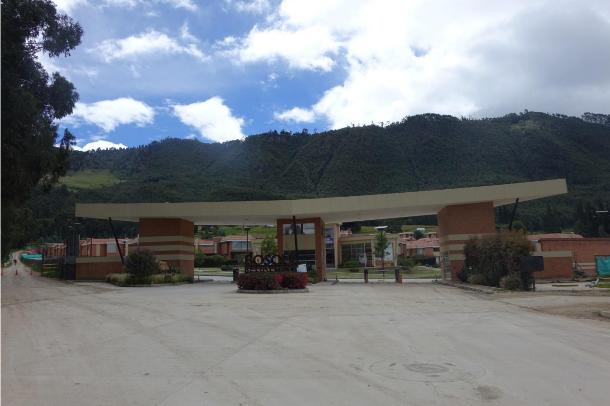
PHOTO 20. ENTRÉE DE HACIENDA DEL RIO
