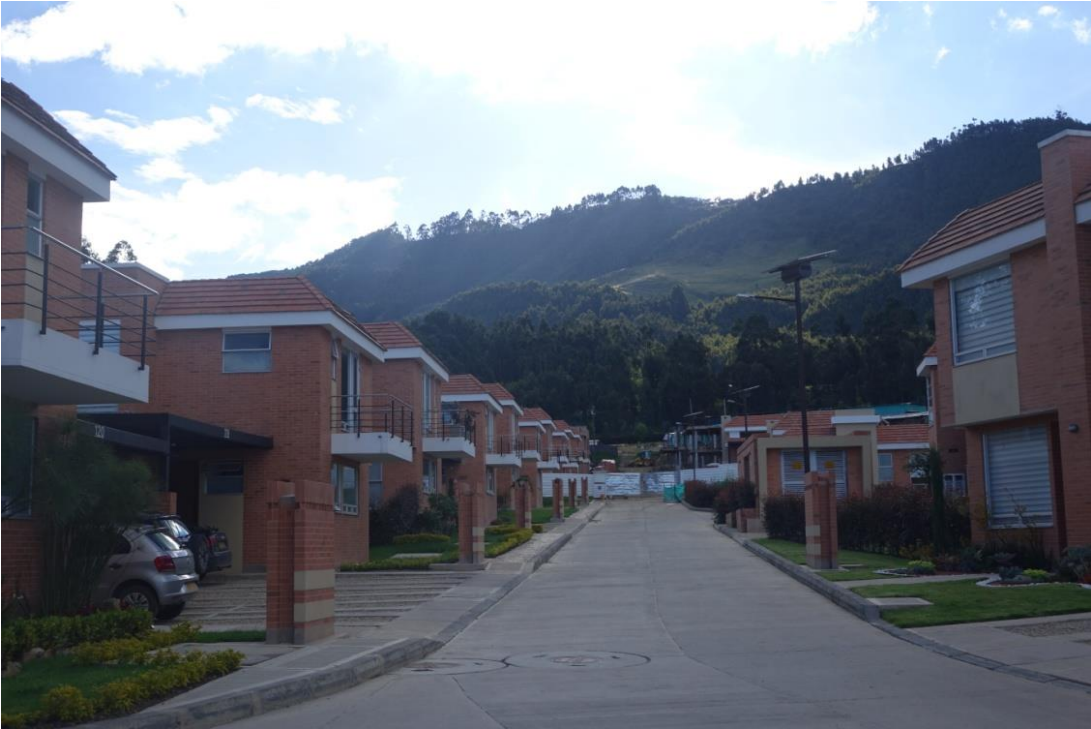
PHOTO 21. CONJUNTO HACIENDA DEL RIO
