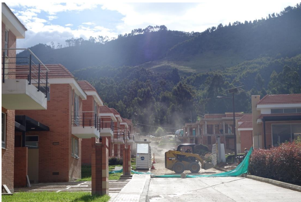
PHOTO 22. LA DEUXIEME ETAPE EN CONSTRUCTION
