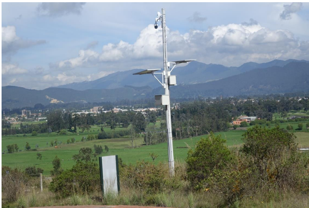
PHOTO 9. LE CHEMIN D'ACCES AU CONJUNTO EST JALONNE DE CAMERAS DE SECURITE SOURCE : ELABORATION PERSONNELLE
