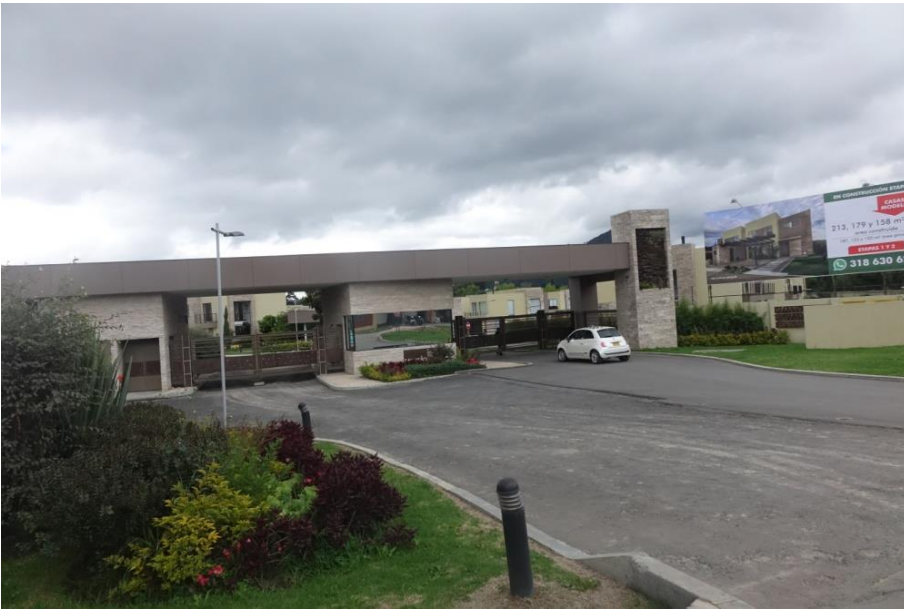
PHOTO 15. ENTRÉE DU CONJUNTO SABANA VERDE
