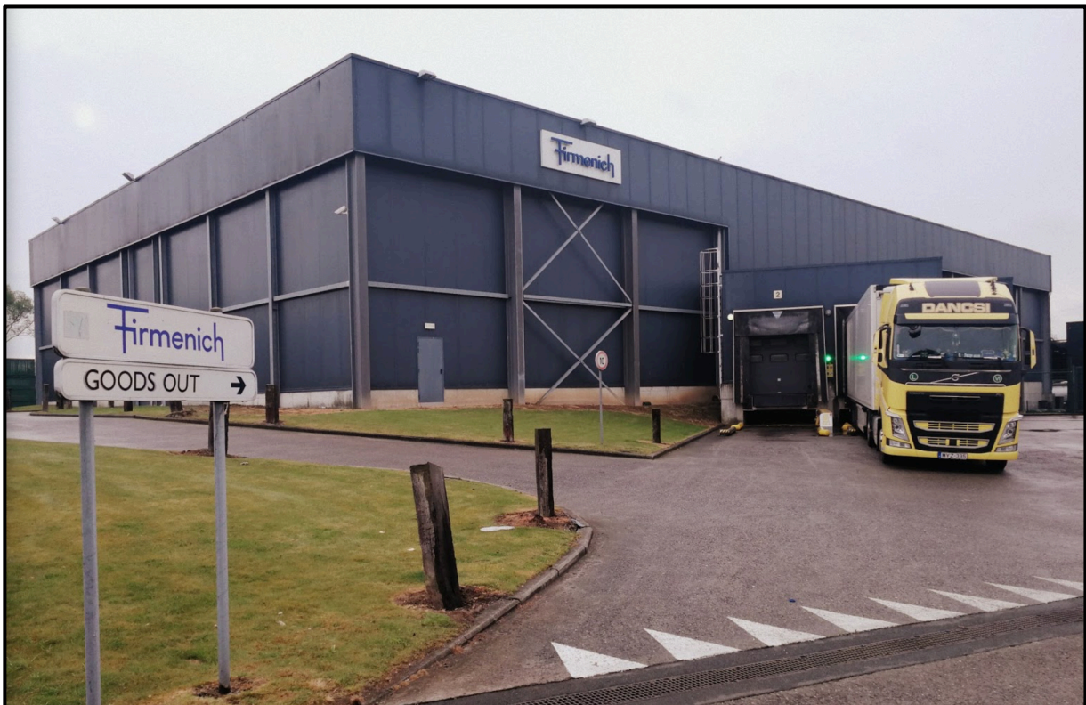
Figure 2 - Photo de l'usine Firmenich à Louvain-la-Neuve (Belgique) - Espace d'expédition des produits finis
