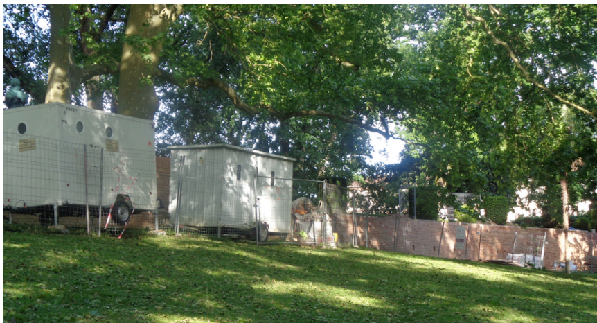
Figure n°15 : Photographie illustrant les travaux en cours sur le mur de soutènement du Parc Rohegude, réalisée par LECLERC Anouk – Mai 2018
