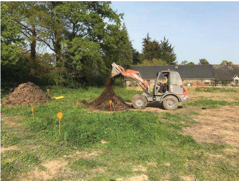
Figure 3 : Mise en place des andains ventilés. Une tranchée a été creusée à la main, un drain y a été insérer puis percé dans de nombreux endroits
