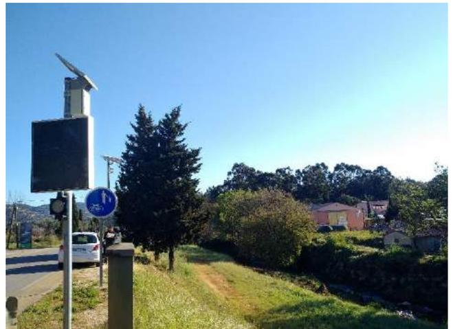
Figure 27: Photo illustrant un feux lumineux "route barrée" en cas d'inondation. Source: Photo personnelle
