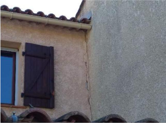
Figure 24: Photo prise chez un habitant illustrant une fissure sur l'habitation provoquée par l'inondation. Source : Photo personnelle
