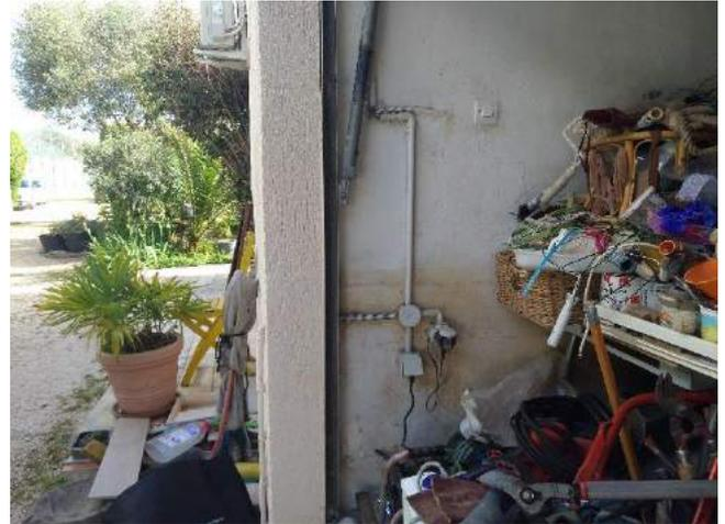
Figure 25: Photo prise chez un habitant illustrant la marque du niveau de montée de l'eau. Source : Photo personnelle
