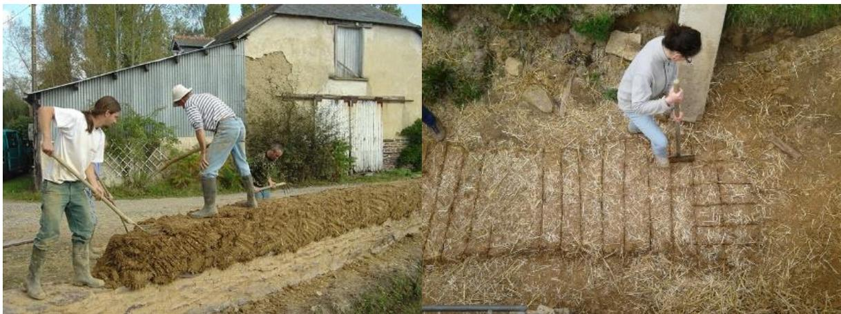
Figure 13 : La technique de la bauge fourchée (Source : AsTerre)/La technique de la bauge découpés (Source : site internet « atelier-alp »)
