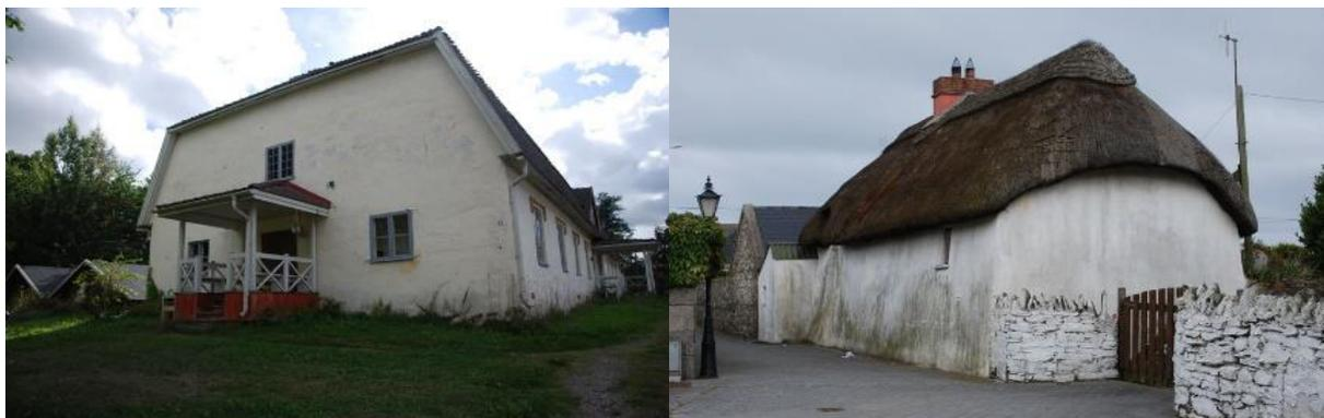
Figure 9 : Maison construite en argile et recouverte de plâtre crayeux, Finlande/Maison en bauge recouvert d'un enduit ciment, Irlande (Source : Terra Incognita)
