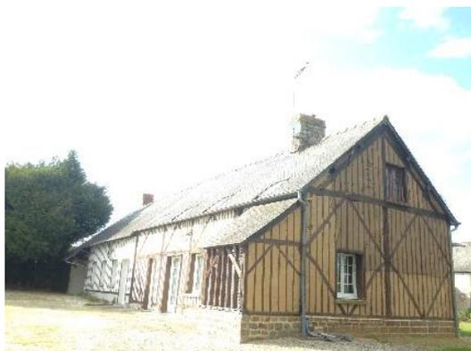
Figure 24 : Habitation avec des trous dans le torchis à cause des oiseaux, Barenton, 04/19 (Source : J.Huret)
