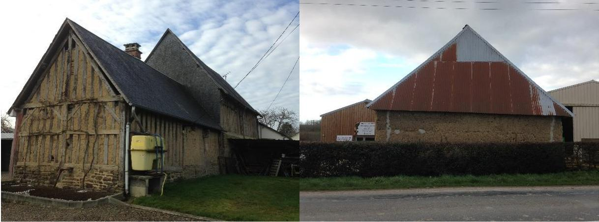
Figure 102 : Gîte en torchis pan de bois à colombes découvertes, Notre-Dame-du-Touchet/Exploitation agricole utilisant le bâti en bauge pour stocker les fruits et légumes, Brecey, 01/2019 (Source : J.Huret)
