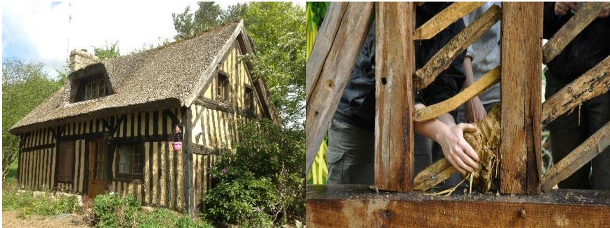
Figure 4 : Maison en torchis pan de bois, Saint-Georges-de-Rouelley, 04/2019 (Source : J.Huret)/Lattis pour accrocher le torchis (Source : site internet « au-milieu-de-nulle-part »)
