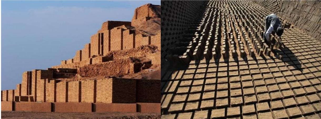
Figure 5 : La ziggourat de Tchoga Zanbil en Iran construite vers 1250 avant Jésus-Christ (Source : CRAterre)/Séchage des briques crue (Source : archeorient)
