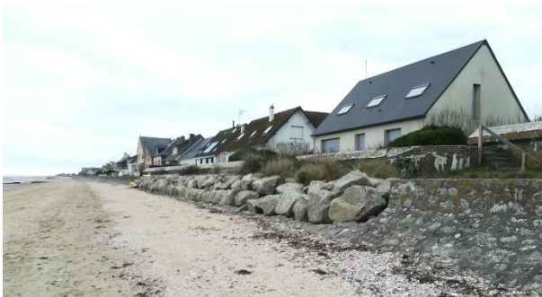
Figure 60 : Photographie d'un perré avec enrochements à Quinéville, P. EMILE, 4/01/19
