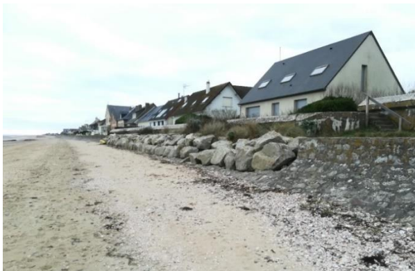
Figure 1 : Photographie de maisons en bordure du littoral à Quinéville, protégées par un enrochement, P. EMILE, 4/01/19
