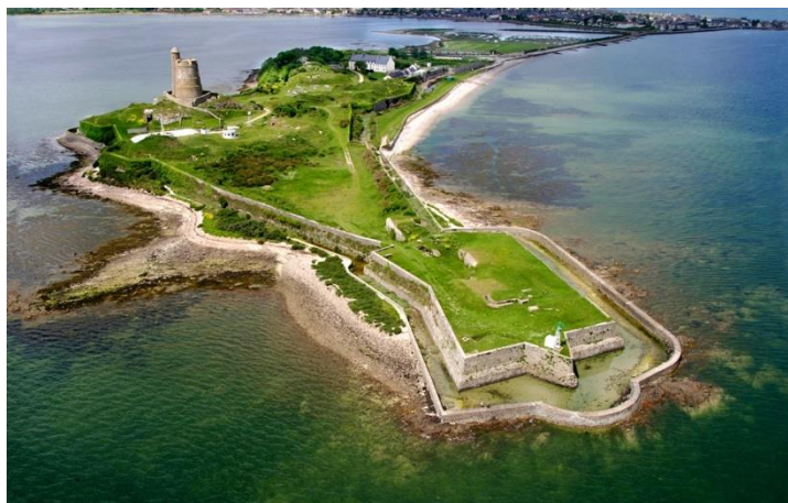
Figure 70 : Photographie de la Pointe de la Hougue et des fortifications sur le trait de côte (sur img.itinari.com )
