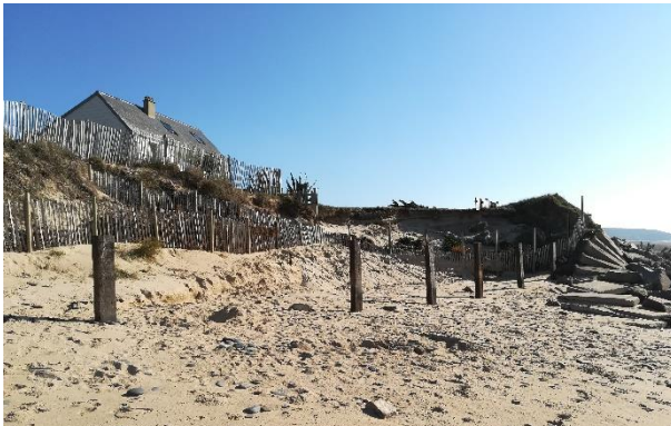
Figure 49 : Photographie d'un cordon dunaire fixé à l'aide de ganivelles pour protéger une habitation au niveau du camping Le Grand large, P. EMILE, 26/02/19
