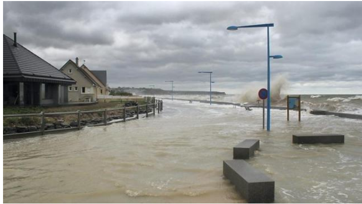
Figure 6 : Photographie d'une submersion marine à Asnelles (14), Ouest-France, 04/11/13
