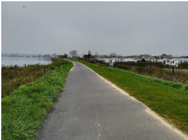
Figure 72 : Photographie du talus protégeant le camping de la Galouette, P. EMILE, 22/03/19
