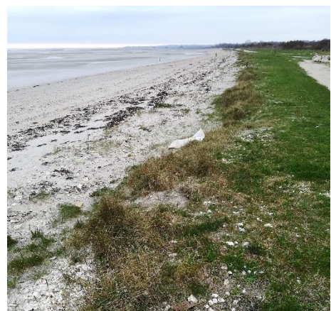
Figure 57 : Photographie d'un tronçon côtier végétalisé au Sud de la Redoute, P. EMILE, 4/01/19
