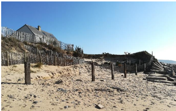
Figure 49 : Photographie d'un cordon dunaire fixé à l'aide de ganivelles pour protéger une habitation au niveau du camping Le Grand large, P. EMILE, 26/02/19
