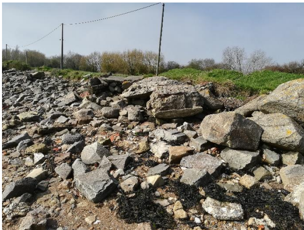
Figure 75 : Photographie des enrochements devant la route côtière au niveau de la Chasse du Bourg, P. EMILE, 22/03/19
