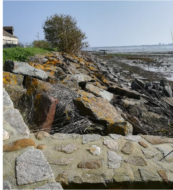
Figure 74 : Photographie des ouvrages longitudinaux situés devant les bâtis industriels de St-Vaast-la-Hougue, P. EMILE, 22/03/19
