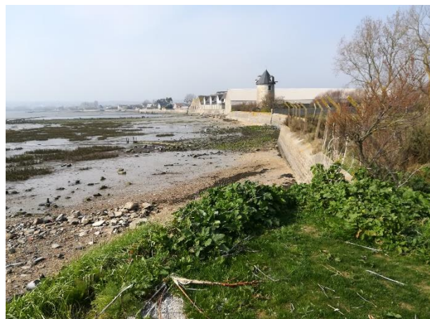
Figure 73 : Photographie des murs bétonnés placés à l'Est du Carvallon, P. EMILE, 22/03/19
