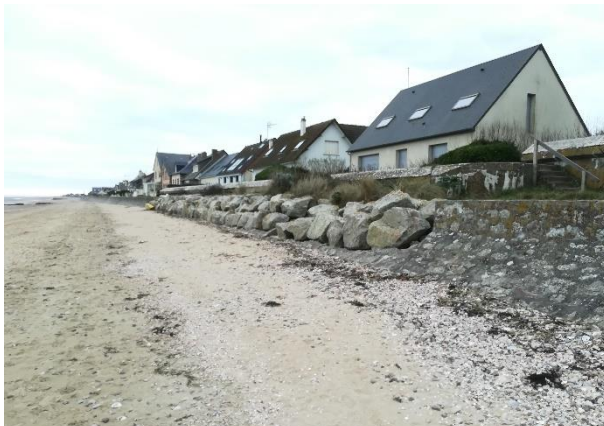
Figure 78 : Photographie des perrés protégeant les habitations à Quinéville, P. EMILE, 4/01/19
