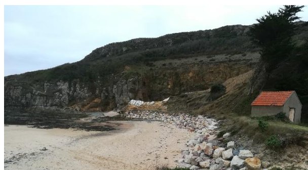
Figure 87 : Photographie de l'enrochement au hameau Le Pou, au Sud du Cap du Rozel, P. EMILE, 4/01/19
