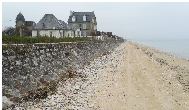
Figure 59 : Photographie d'un perré au Sud de Quinéville, P. EMILE, 22/03/19
