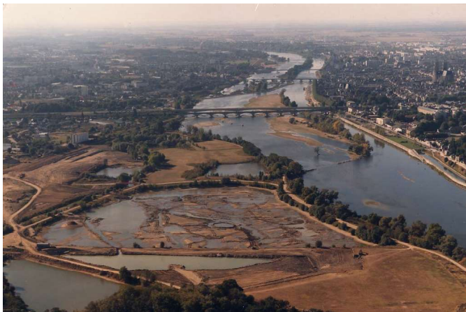
Figure 6: Creusement du bassin de l'île charlemagne [18] (Orléans, archives Orléans Métropole, 1985)
