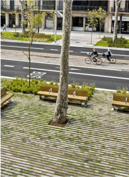
Fig.14 – Passage de St.Joan - Revêtement perméable - Source : [15] (Lyanne van Diepen)
