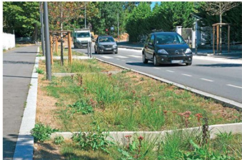
Fig.15 – Les Mureaux -Tranchée végétal de récupération des eaux de voirie - Source : [16] (Agence Quatrevingtdouze)
