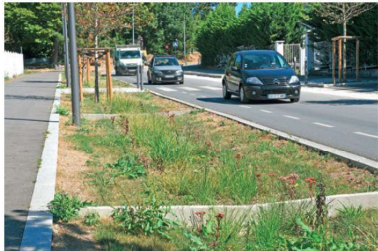
Fig.15 – Les Mureaux -Tranchée végétale de récupération des eaux de voirie - Source : [16] (Agence Quatrevingtdouze)
