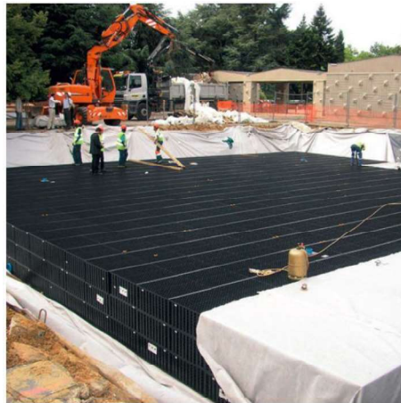
Fig.16 – Clamart – Bassin enterré de récupération des eaux pluviales - Source : [17] (APUR, 2016)
