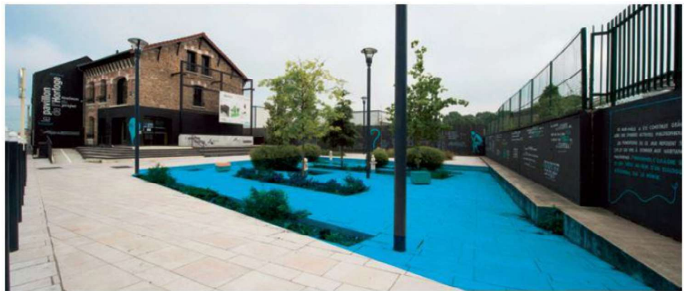
Fig.17 – Romainville – L'espace public inondable - Source : [17] (ETP Est Ensemble, Gael Kerboal)
