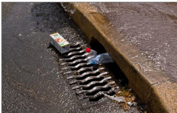
Figure 2 : L'eau pluviale-pollution : déchets collectés par un avaloir pluvial
