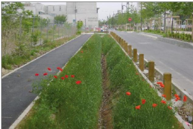
**Figure 3 : l'eau pluviale - ressource (exemple de noue d'infiltration)**
