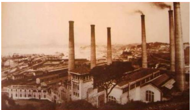
Figure 12: Photo, Ancienne usine électrique de Cap Pinède
