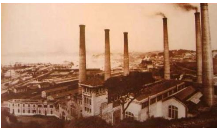
Figure 12: Photo, Ancienne usine électrique de Cap Pinède
